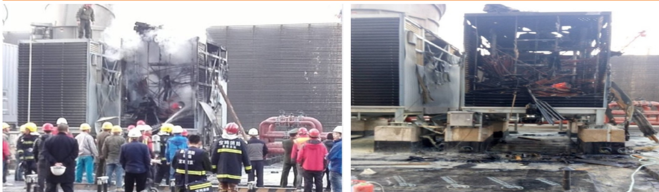
宝鸡一商务楼楼顶着火现场（水渍损失小）
